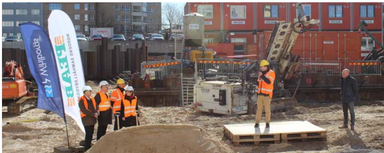
Den 10 mars togs första spadtaget på Polisen 4, där Wihlborgs bygger ut Helsingborgs tingsrätt med 4 000 m 2 och gör en ombyggnad av 5 000 m 2 .
